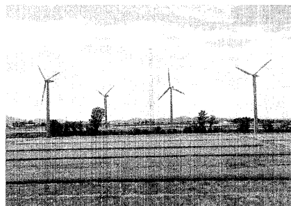
図 2 山形県立川町 (最上川側) 水田の中の集合型風力発電所 (600 kW×4 台, 400 kW×2 台, 合計 3 200 kW)
