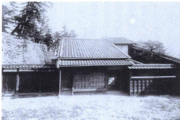
図2. 移築直後の旧宅 (明治42年) 3)
