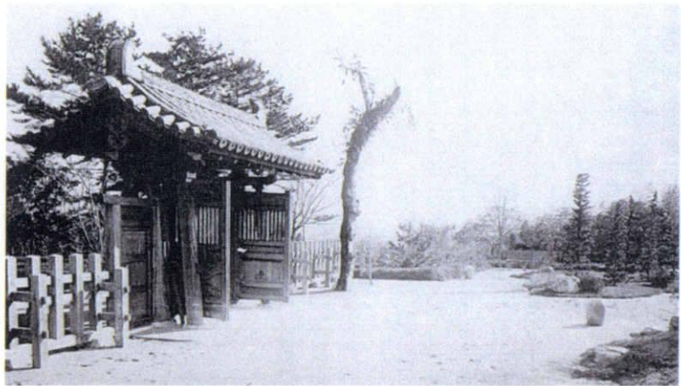
図 3-11. 「附属工事」大正時代の表門*9
