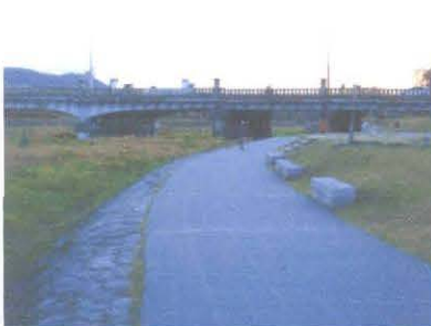
写真10 加茂川右岸①(線の視点場)
