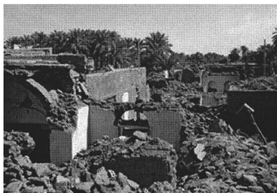
写真 1.2 バム地震における Adobe 建造物の被害 1-4)
