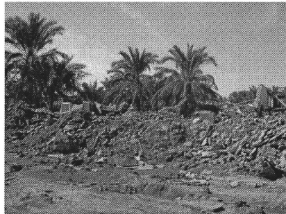
写真 2.7 Adobe 建築物の完全崩壊状況
