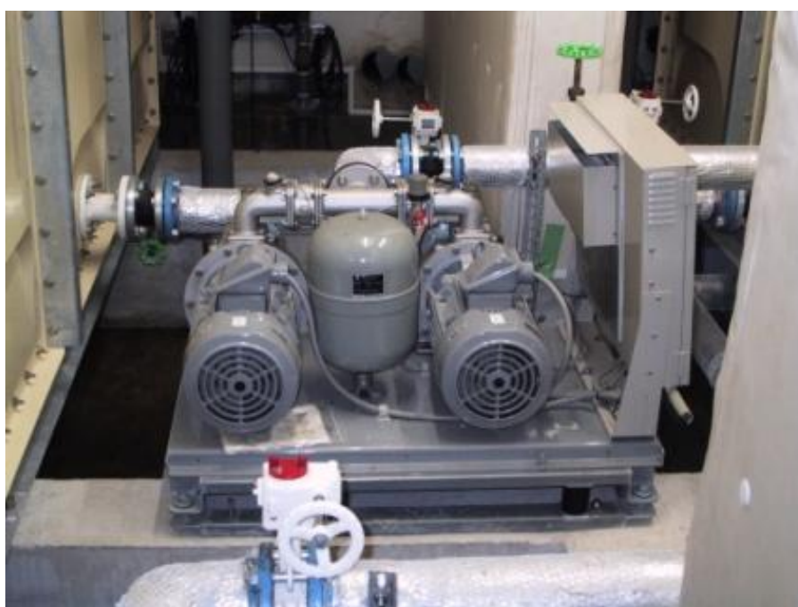
図 2-2 直送方式の給水ポンプ
