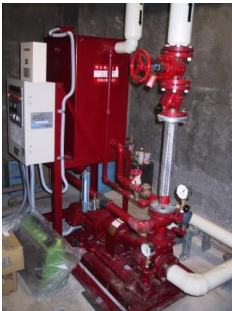
図 2-3 高置水槽方式の給水ポンプ
