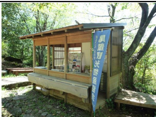
写真 4-2-13-5 尾鷲観光物産協会の建物
