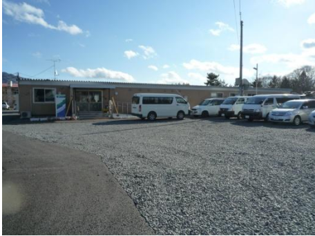
写真 4-2-7-4 駐車場の様子①
