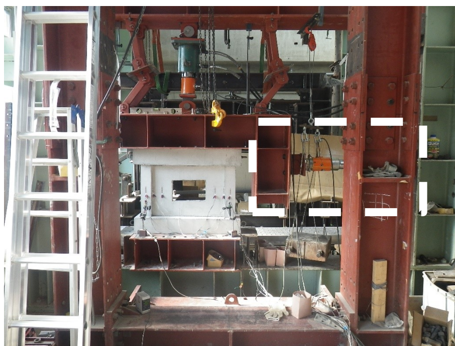
写真 3.2.2 試験体設置状況（反曲点高さ比 1.0）
