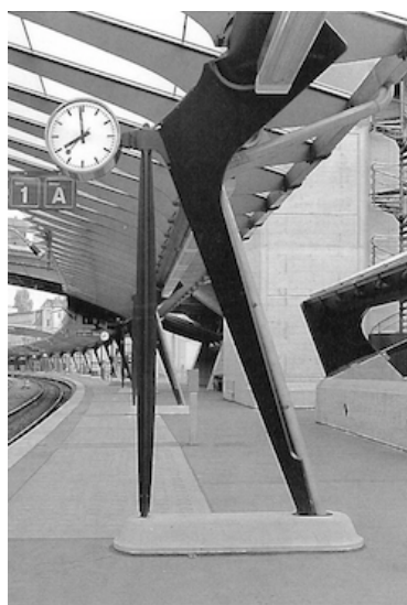
図 2.1.7 モーメント図と造形の比較 _Stadelhofen Station
