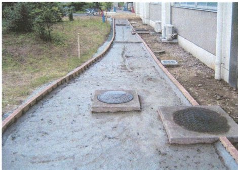
写真 6.5 路床のセメント被膜、縁石状況(D3 区画)
