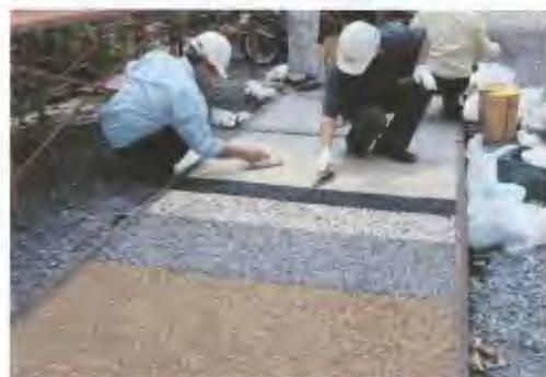
写真 5-10 複層ポーラスコンクリート技術の指導
