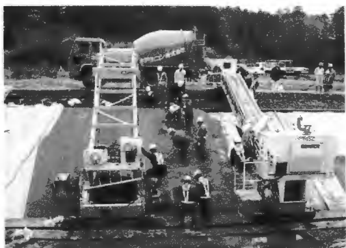
写真 2.5.1 護岸工事における施工機械 43)
