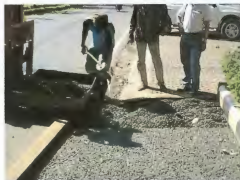
写真 5-4 現場への POC 打設
