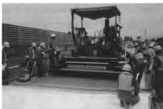
写真 2.5.2 道路用フィニッシャ (ポーラスコンクリート) 44)
