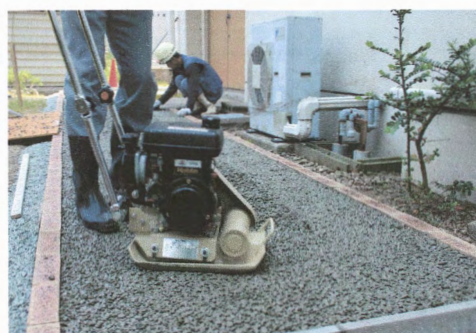
写真 6.8 振動締めめ機による基層の 締めめ (B 区画)
