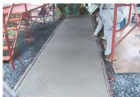
写真 5-8 ポーラスコンクリート打設状況
