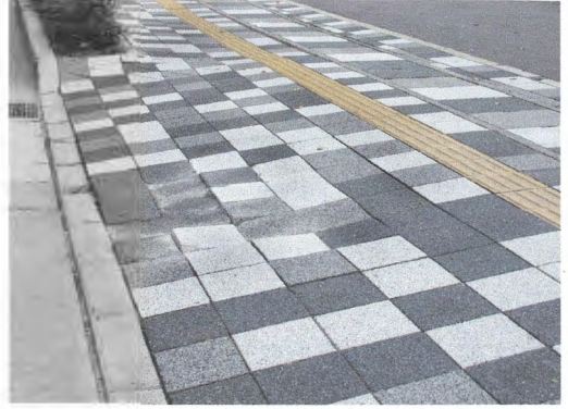
写真 6-2 傷んだインターロッキング舗装
