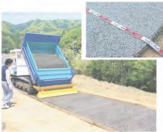
写真1 打設機の運転状況(打設幅 2.05m)
