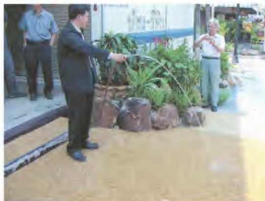
写真 5-18 試験施工箇所の透水状況確認
