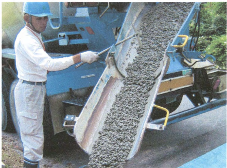
写真 6.6 アジテータ車からのポーラスコンクリートの排出状況
