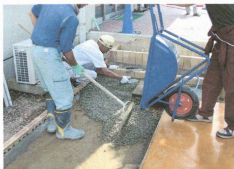
写真 6.7 ポーラスコンクリートの打設 (C 区画)
