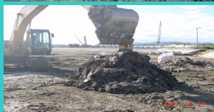
Figure 4. 建設濁水調整池底泥の固化処理
