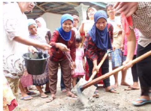
(D) Mixing concrete
