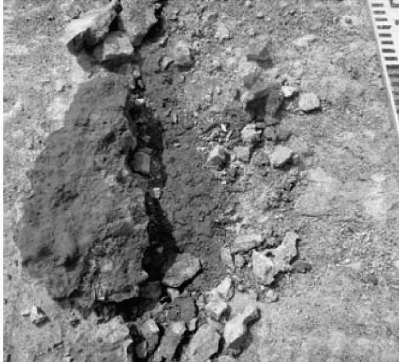
写真2.1 寒冷地で供用されたRC床版が砂利化した状況<sup>18)</sup>
