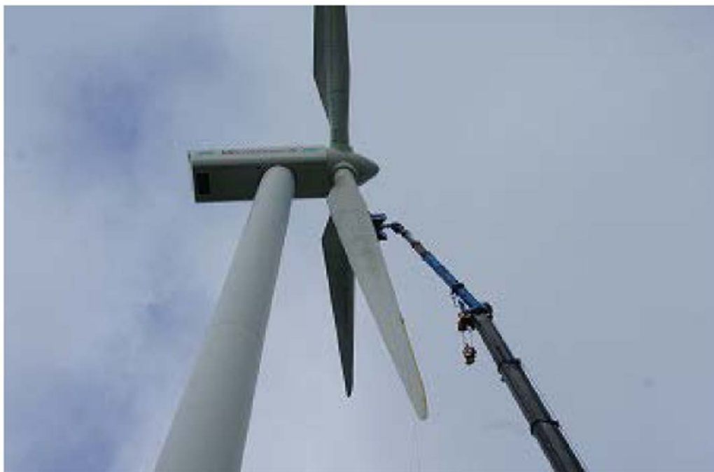
図 5.1 クレーンを用いた、1.75MW 風車翼前縁への電極設置
