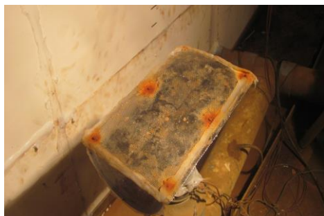
写真 2.1 ハーフパイプ型流入口流入面
