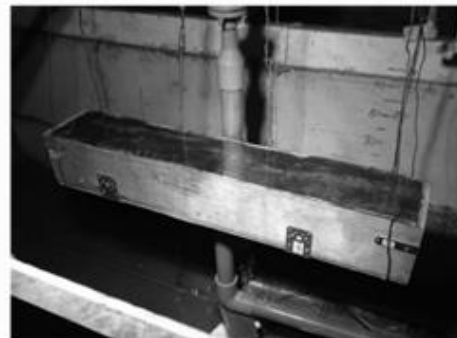
(b) ボックス型ディフューザー L 1.0m×W 0.15m×H 0.15m
